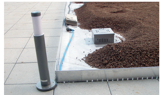
Posizionamento di un pozzetto di ispezione per scarico a pavimento, profilo di separazione drenante tra pavimentazione e verde pensile, punto luce, predisposizione dell'impianto di irrigazione.
